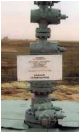
Слика 5.35 – Конзервација бушотине
